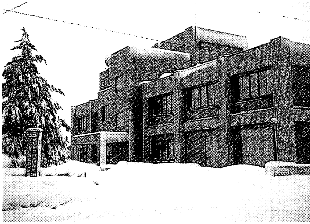
(写真2) 新庄雪氷防災研究所支所構内に建設された雪氷防災実験棟
