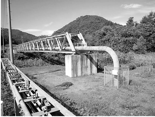
図7：新潟～仙台間のパイプライン。通常地下に敷設し、川を横断するときだけ地上に出る。 (宮城県七ヶ宿町にて、松木兼一郎氏撮影)
