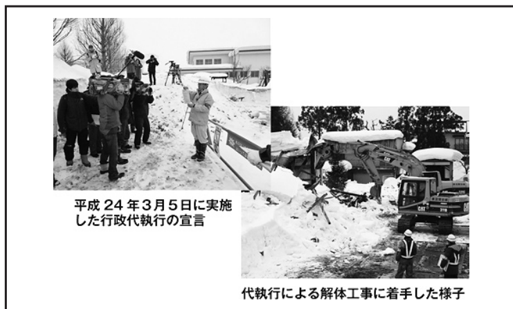
図4 行政代執行による危険老朽空き家の解体工事の例(秋田県大仙市) 19
